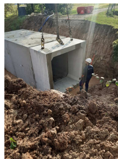
Réalisation d'un pont à Le Boulvé sur la rivière « Le Saint-Matré »
